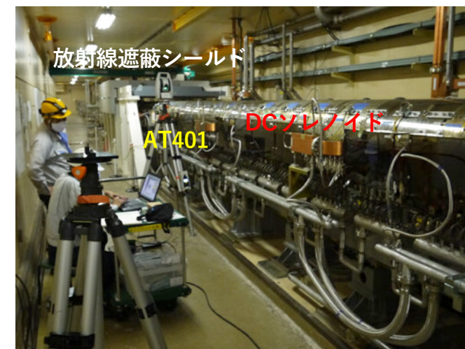
図5 レーザートラッカー測量
