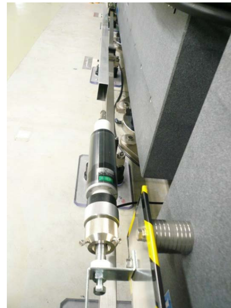
伸縮計 スーパーインバー線使用
