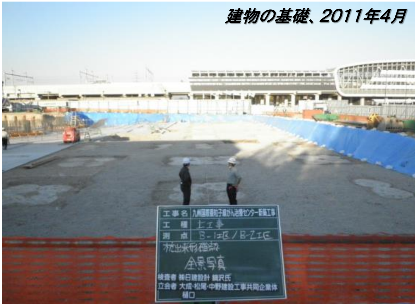
深層混合処理工法
