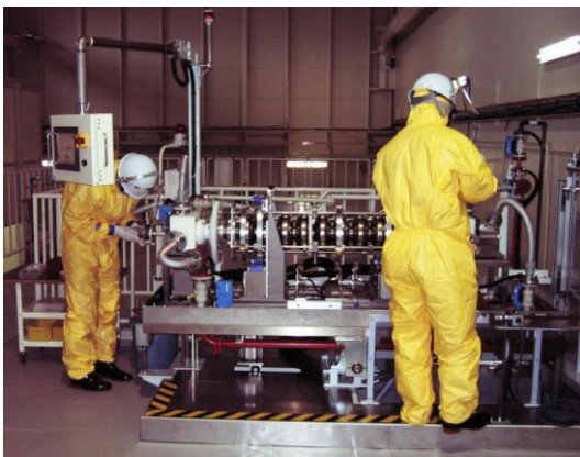
写真1 EPベッドへの空洞取り付け作業
