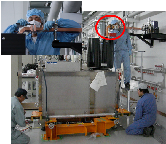
図8 クライストロン締結の様子
